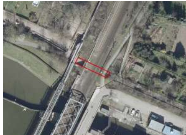
Lage der Unterführung der Riedbahn, dem Bindeglied zwischen den beiden Teilbereichen Neckarplatt und Pfeifferswörth
