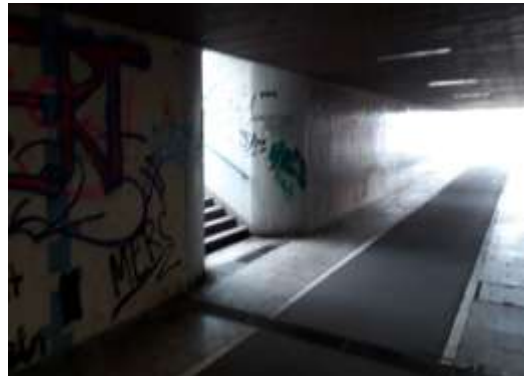
Unterführung der Feudenheimer Straße zum Teilgebiet Neckarplatt
