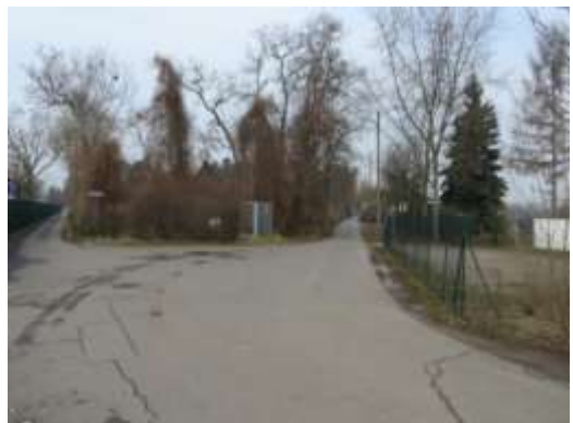
Kreuzungssituation Neckarplatt / Am Neckarkanal
