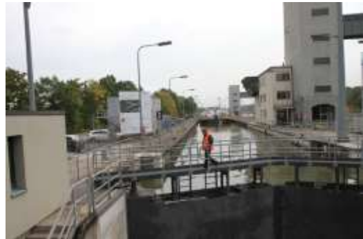
Attraktionspunkt Schleuse am Neckarkanal
